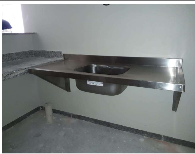
INSTALAÇÃO DAS BANCADAS E LAVATÓRIOS DE INOX
